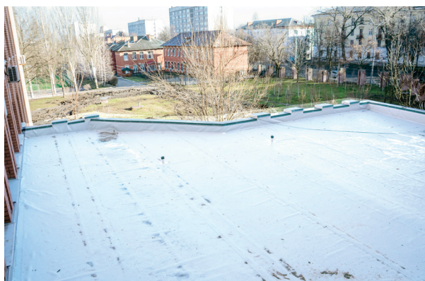
проведено ремонт покрівлі А4-1 (над бібліотекою)
