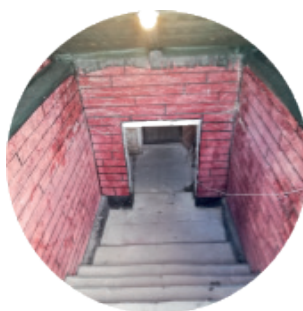
Огляд підвального приміщення
