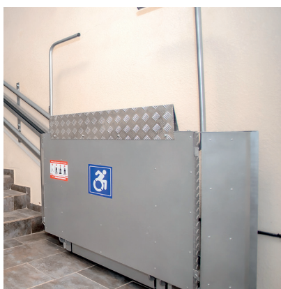
В укритті встановлено два підйомники для осіб з інвалідністю
